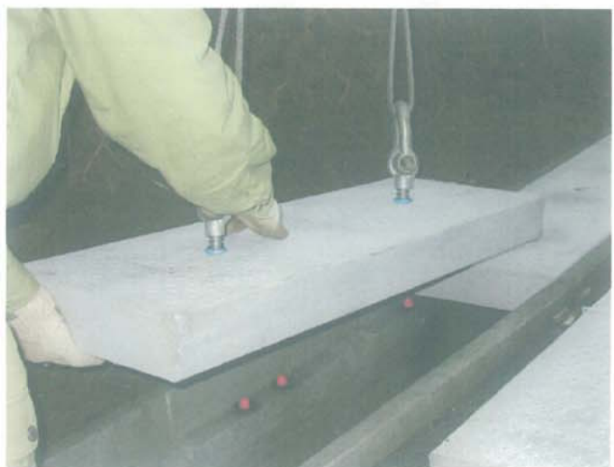
1m蓋施工状況
